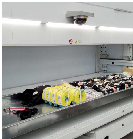
External bay lighting / 外艙式照明
